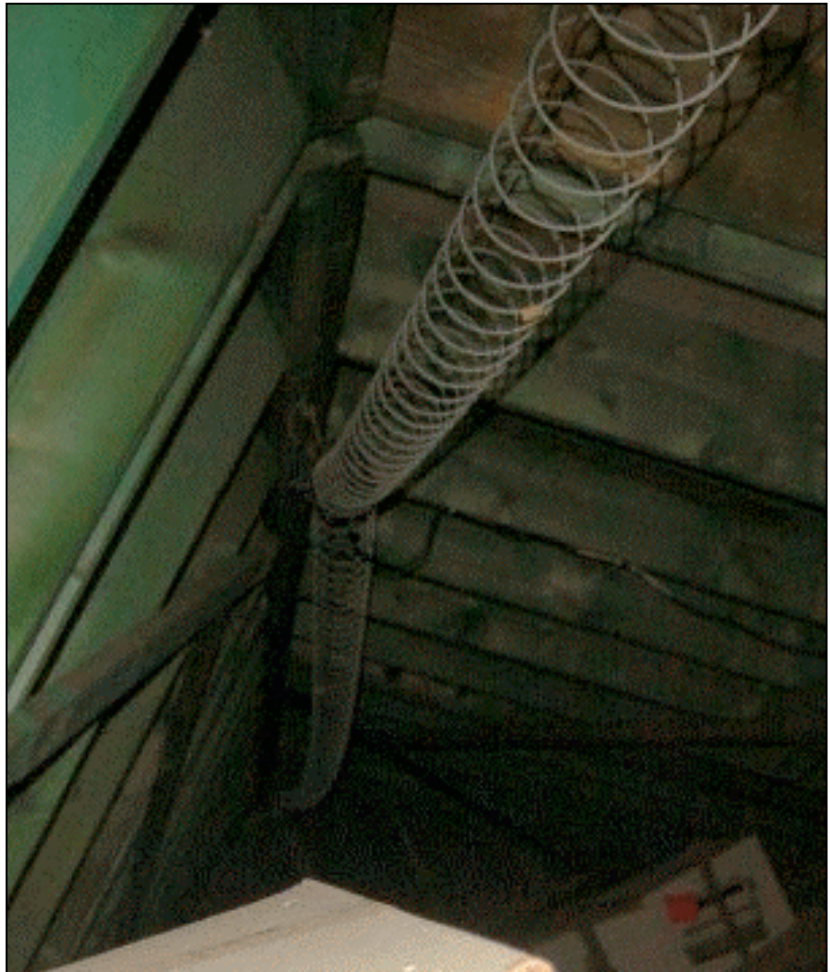
La Slinky repliée ou plutôt « compressée ». La latte en dessous donne une idée de ses dimensions. On peut distinguer le T central, le moulinet (à acheter aux puces car bien moins cher), la SO239 en dessous du T, les lattes d'espacement blanches et les pinces d'extrémités au bout de leur fil souple.
